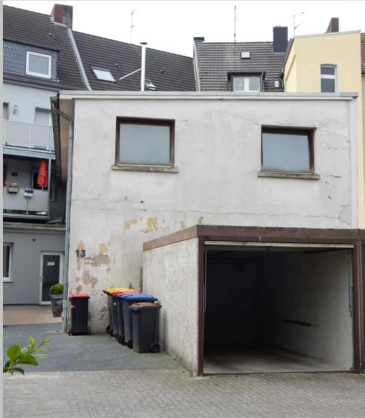
Fassadensanierung Duisburger Str. 26
